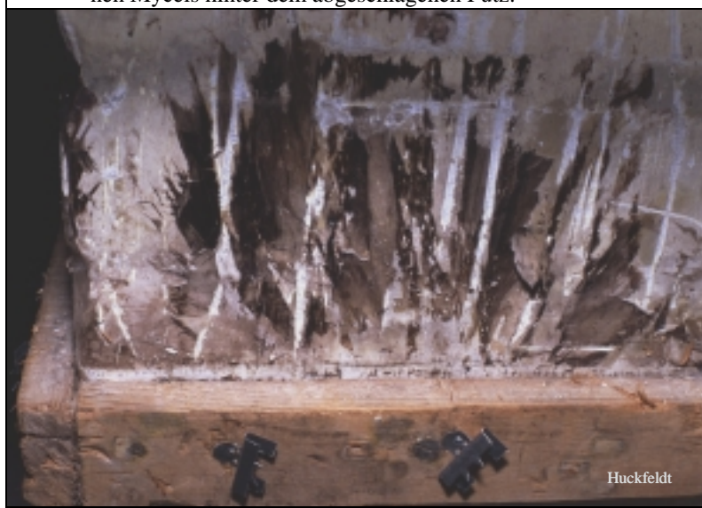
Abb. 2. Dunkles bis fast schwarzes Mycel des Echten Hausschwammes.
