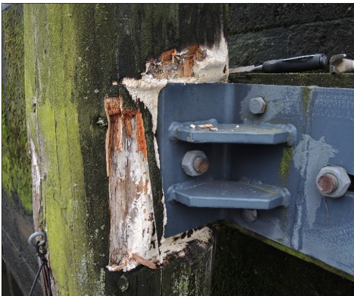
Abb. 61: Braunfäule-Erreger: Gelber Porenschwamm / Gelbe Braunfäuletramete ( Antrodia xantha ); Fundstelle: Hamburg; Am Sandtor kai; Südseite des Hafenbeckens; Dalben im Museumshafen, Probenpunkt 7; etwas unterhalb des Balkenkopfes.
