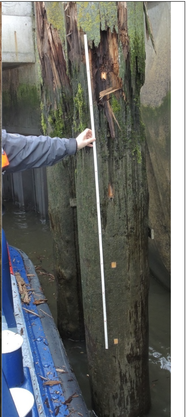
Abb. 72: Hamburg, Hafen – Großer Grasbrook, erstes Deko-Dalben-Paar am Anleger Elbphilharmonie, Dalbe mit Verteilung der Probenpunkte; erster Probenahme-Punkt ca. 50 cm über der Wasseroberfläche; massive Schaden über dem Bereich des Tidenhubes; Probennahme: 30.03.2017.
