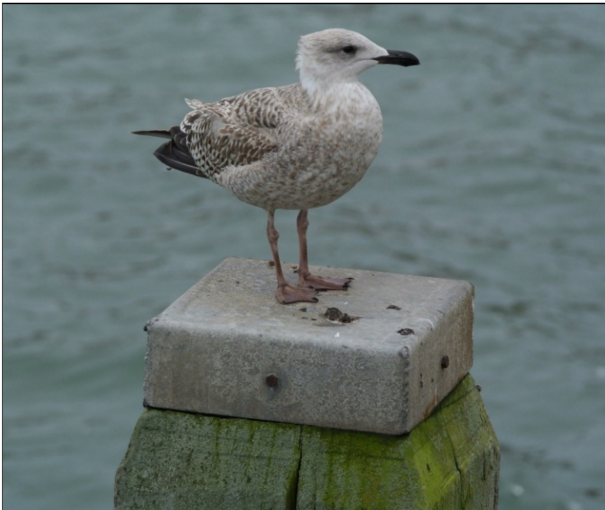
Abb. 5: Die Abdeckung schützt das Hirnholz und Risse der Dalbe vor Niederschlägen, auch der Nährstoffeintrag wird vermindert; nur ist sie aufgrund der Abschrägung etwas klein (Ostsee).
