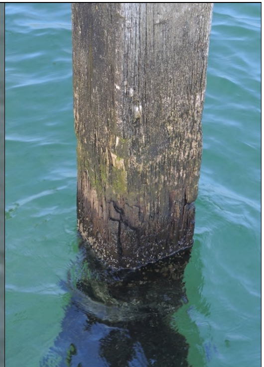
Abb. 6: Typische Dalbe in der Ostsee: der Tidenhub vgl. klein und die Zonen dicht gedrängt; unter Wasser mit tierischem Besatz.
