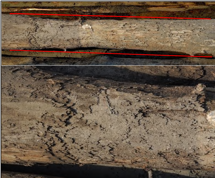
Abb. 41: Dalbe mit Bohrsessel- ( Limnoria lignorum ) und Bohrmuschel-Befall ( Teredo navalis ) mit deutlicher Verjüngung im Befallsbereich.
