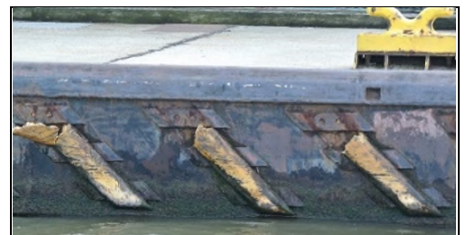
Abb. 3: z. T. zerstörte Kunststoff-Abstandhalter, die Kunststoff-Reste gelangen ins Wasser und schwimmen ins Meer.
