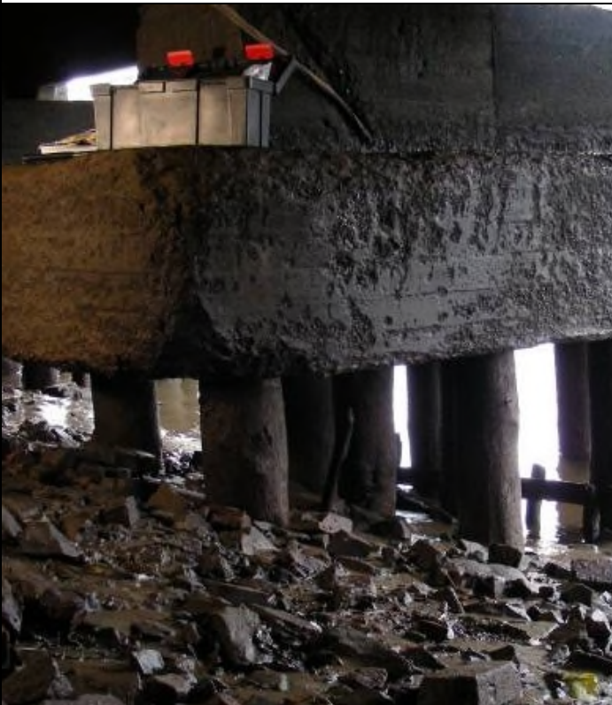
Abb. 30: Hamburger Hafen: Bereich der Untersuchung; vordere Pfahlgruppe, rechte Reihe, 1. Pfahl von der Uferseite im Bereich des Tidenhubs; Pfahlgruppe liegt täglich zweimal eine Stunde frei.
