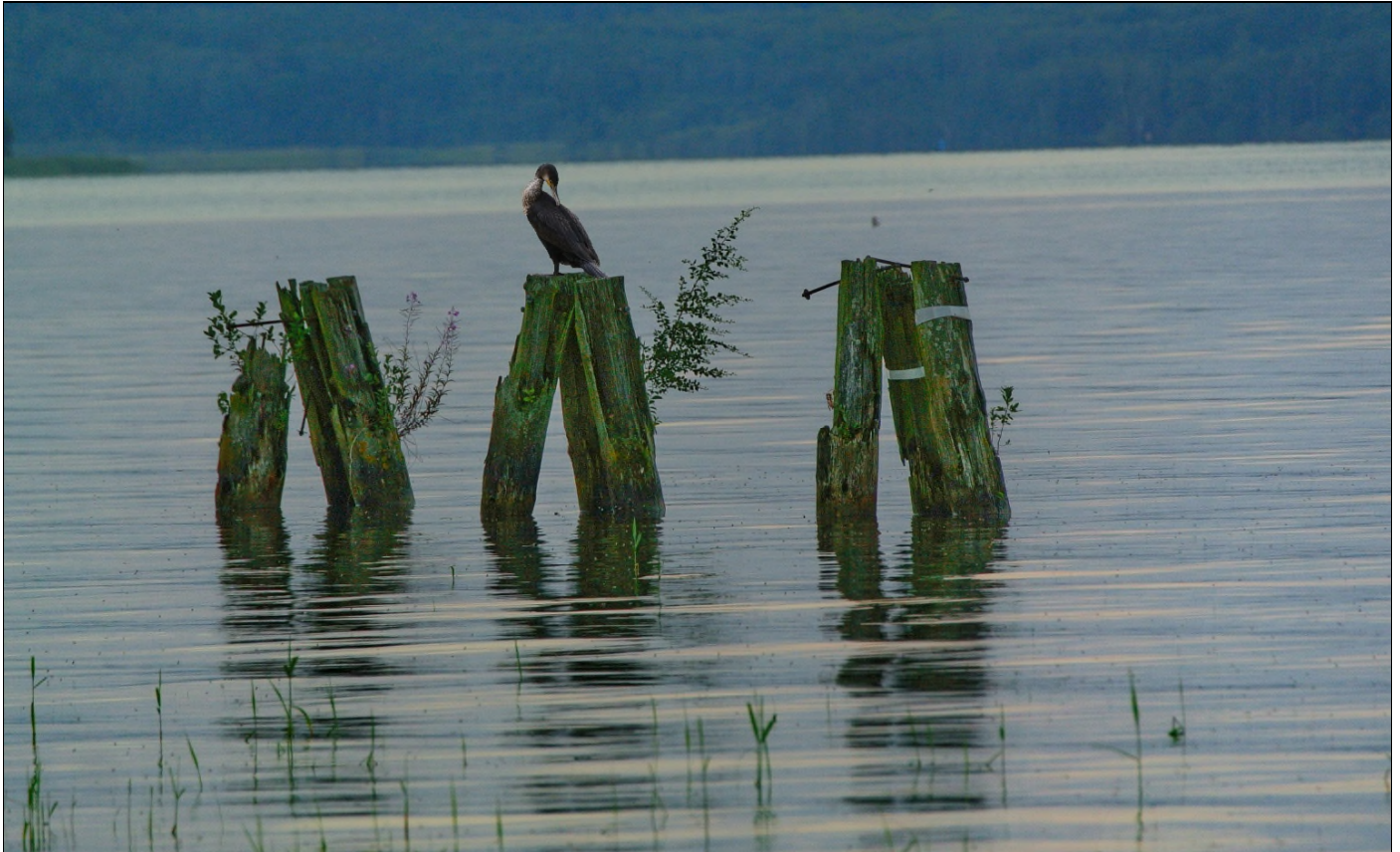
Abb. 2: Alte Dalben: Die freiliegenden Metall-Verbindungen zeigen im oberen Teil den Verlust der Holzsubstanz an.
