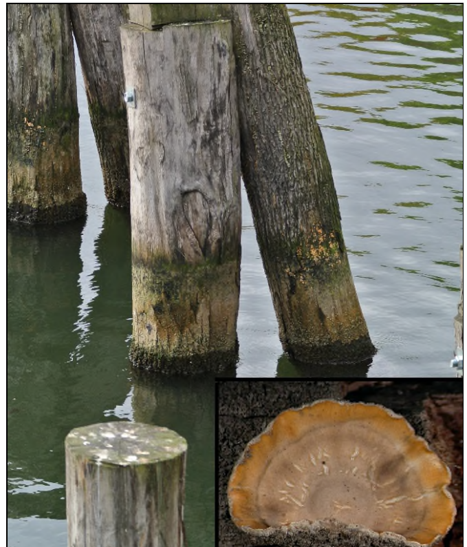
Abb. 60: Lübecker Hafen: Striegeliger Schichtpilz ( Stereum hirsutum ) an berindeter Eichenholz-Dalbe; Befall des Splintholzes; Eckbild: Fruchtkörperdetail.
