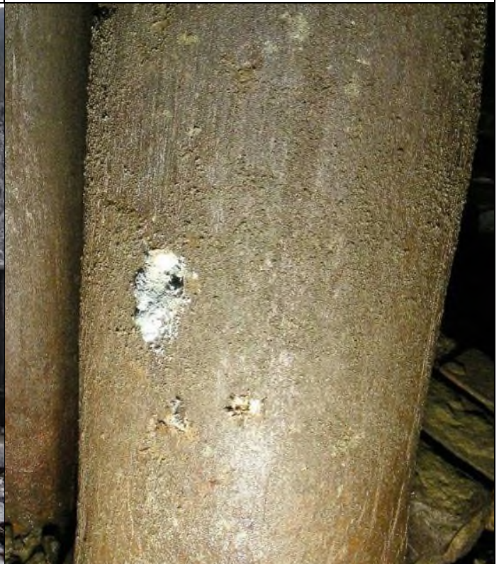
Abb. 31: Gründungspfahl einer Lagerhalle im Hamburger Hafen (Tidezone). Heller Bereich: Bohrloch der Probenentnahme zur mikroskopischen Untersuchung des Gewebes.
