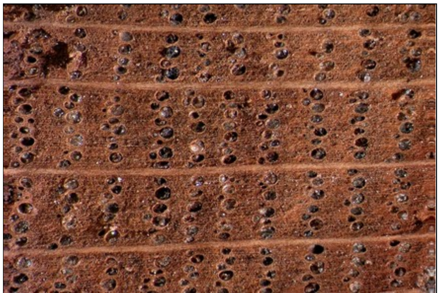
Abb. 8: Typisches Moderfäule-Schadensbild an Eichenholz. Die Fäule-Schäden ist am feuchten Holz kaum zu finden.
