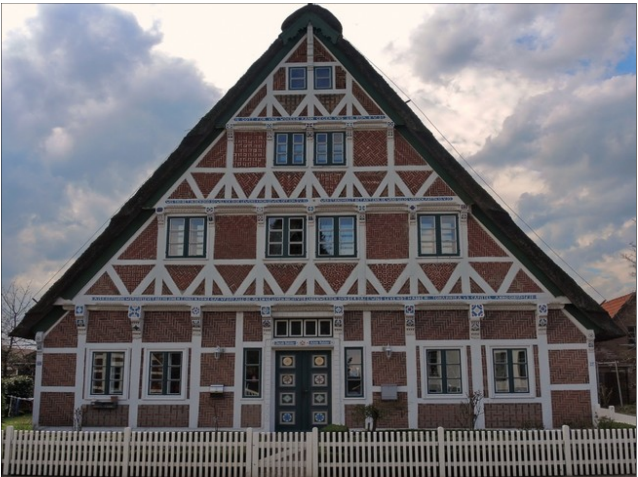
Abb. 1: Typisches norddeutsches Fachwerkhaus an der Elbmündung; bauliche Holzschutz-Maßnahmen: auskragende Geschosse und Dachüberstand.
