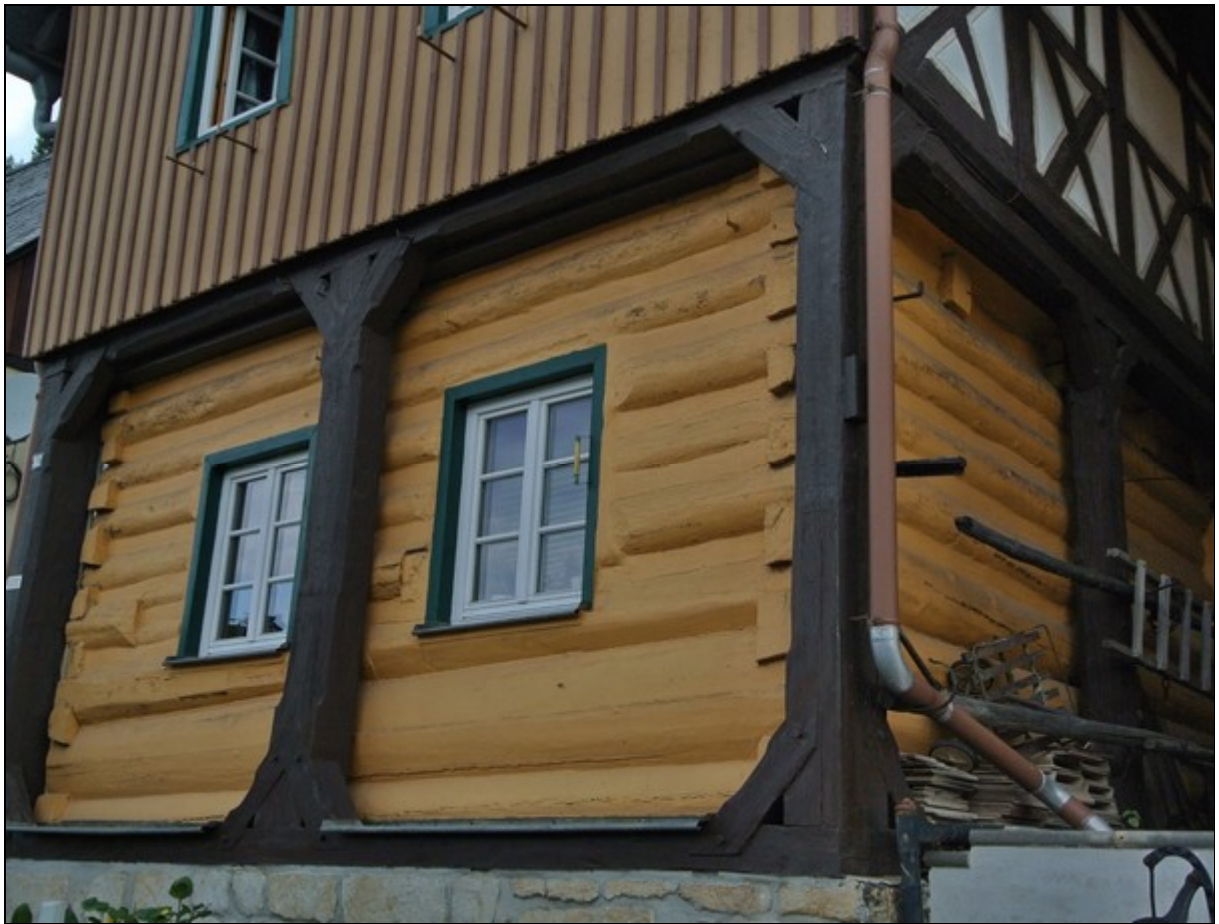
Abb. 17. Eines der wenigen Umgebinde-Fachwerkhäuser mit einer noch vorhandenen Schwelle, i.d.R. fehlt diese. Viele Details sind modern, helfen aber, Fäulepilze fernzuhalten und damit Original-Substanz zu bewahren - ein lebendiger Kompromiss.
