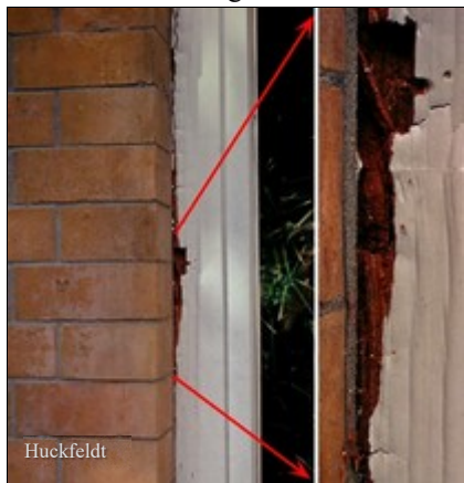
Abb. 4: Braunfäuleschaden mit Würfelbruch durch Echten Hausschwamm ( Serpula lacrymans ) an einer schattigen Fensterseite; das Fenster wird vom Mauerwerk her angegriffen, denn der Hausschwamm durchwächst feuchtes Mauerwerk auf der Holz-Suche.
