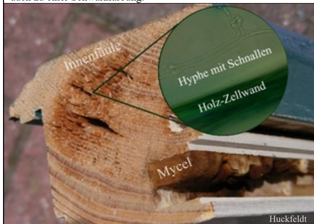
Abb. 3: Braunfäule durch den Tannenblättling ( Gloeophyllum abietinum ) an einem Fensterflügel: typische Innenfäule mit muschelähnlichen Bruchbild bei bewittertem Holz; im Kreis ist eine mikroskopisch kleine Hyphe zu erkennen
